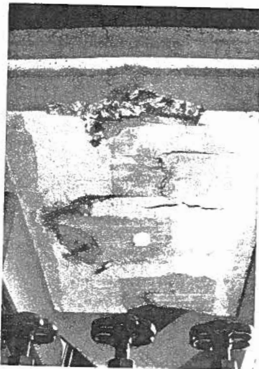
Fig. 19. Brudstedet i Tryksiden. Brudet skete midt paa Spændvidden, hvor der laa 3 høje Blokke, som alle knustes.
