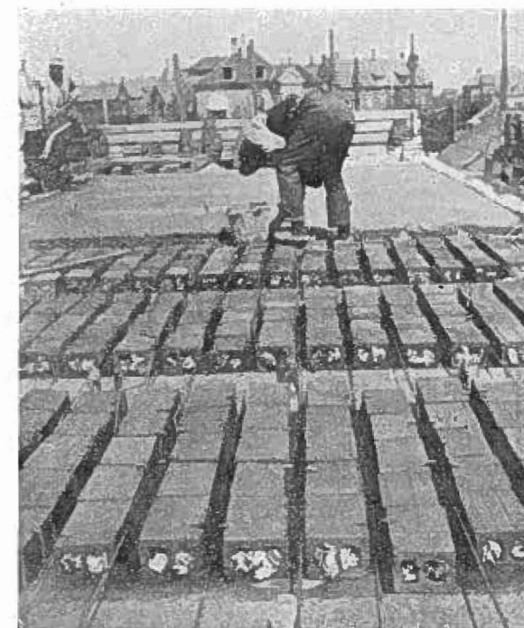
Fig. 2. Blok Nr. 8 i Plader mellem T-Bjælker. Loft over Gymnastiksal i La Cour Vejens Skole. Foraar 1910
